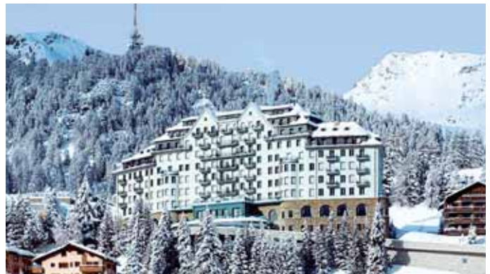
Im 5-Sterne-Hotel Ritz Carlton in St. Moritz wird das Abwasser zur Wärmegewinnung genutzt.
