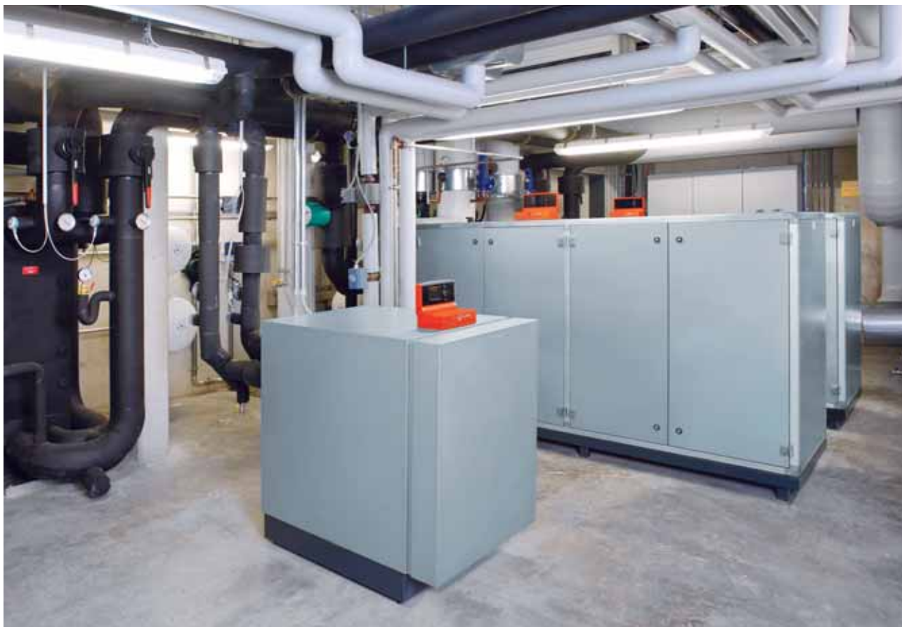
Sole/Wasser-Wärmepumpen Vitocal 300-G Pro und Vitocal 300-G
