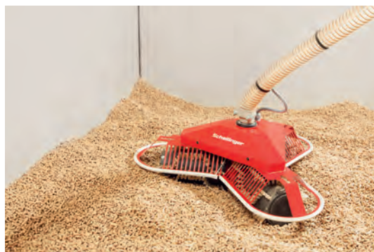
Lagerraum mit Zuführung zum Pelletkessel durch Maulwurf-System
